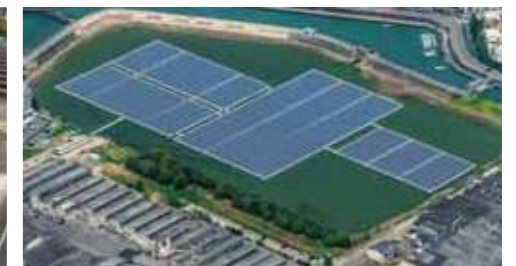
水上フロート式太陽光発電所
