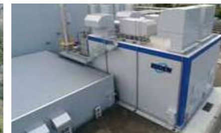
ガスエンジンコージェネレーションシステム
